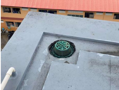
หัวรับน้ำฝน (Rain Drain)
